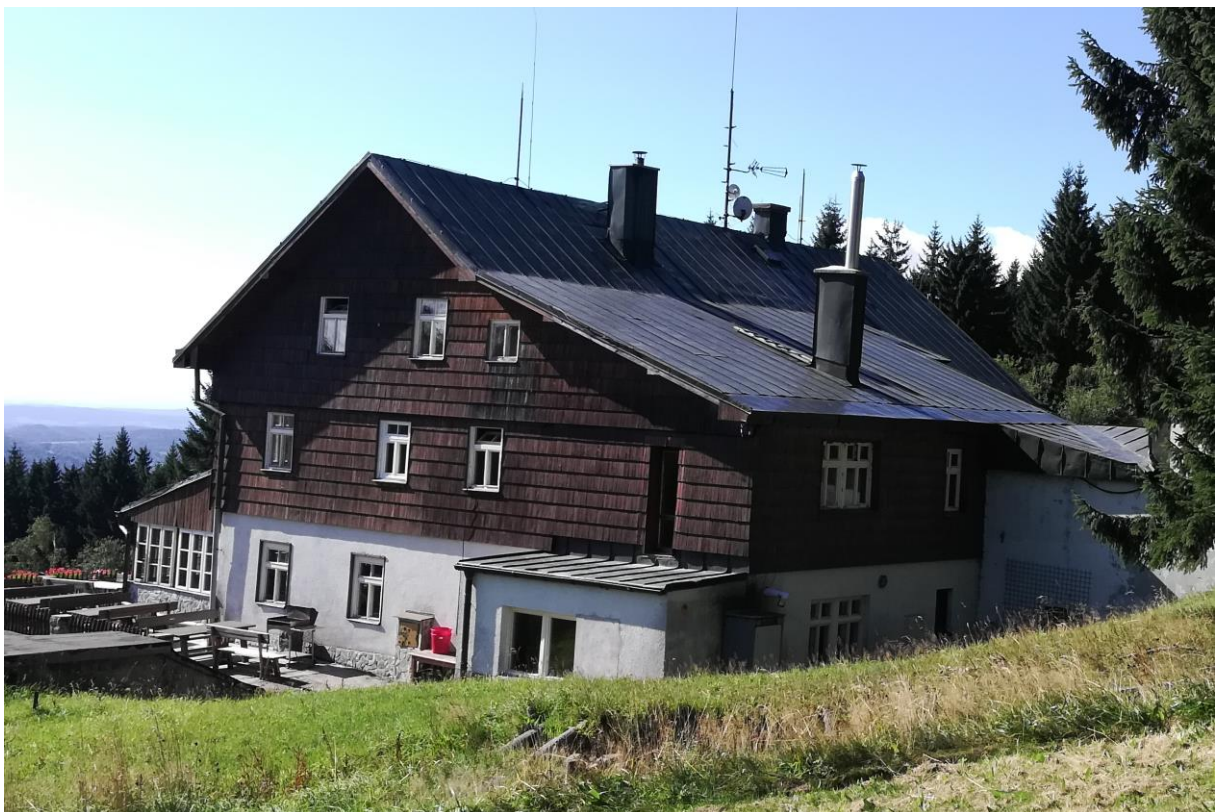
Obrázek 8: Pohled na objekt ze severovýchodu
