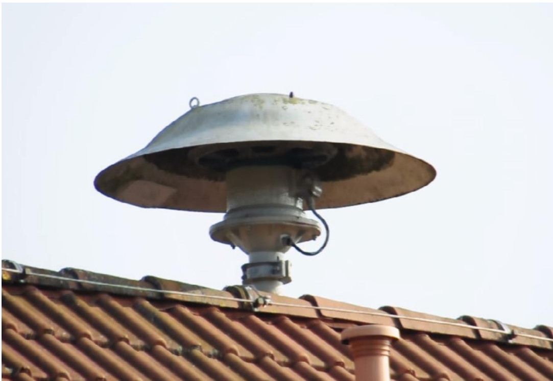
Obrázek 1 - Mechanická siréna DS 977 (zdroj: www.feuerwehr-porschdorf.de.vu )
