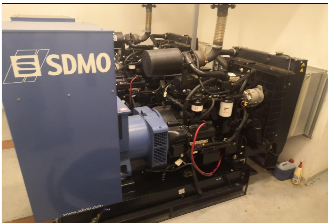
Obrázek 17 – Záložní agregát pro napájení KOPIS HZS SčK – zdroj vlastní
