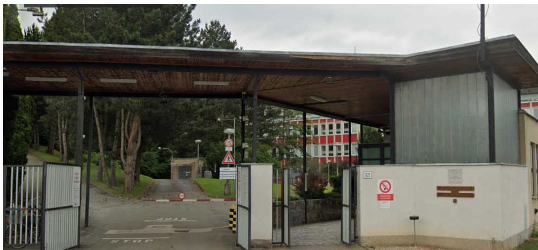
Obrázek 9 - Současný hlavní vjezd a vchod do areálu Bioster a.s. (červen 2019) [36]
