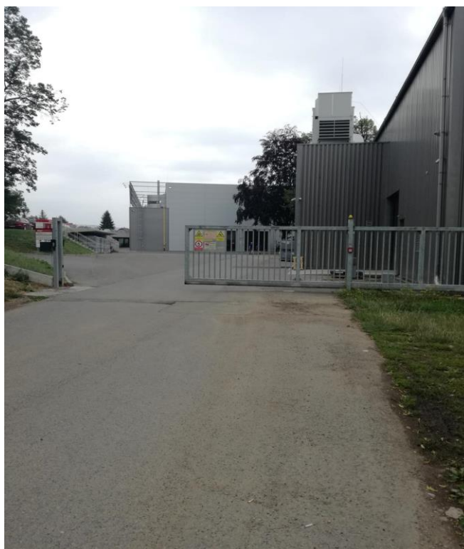
Příloha 3 - Příjezdová brána pro nakládku a vykládku (zdroj: vlastní)
