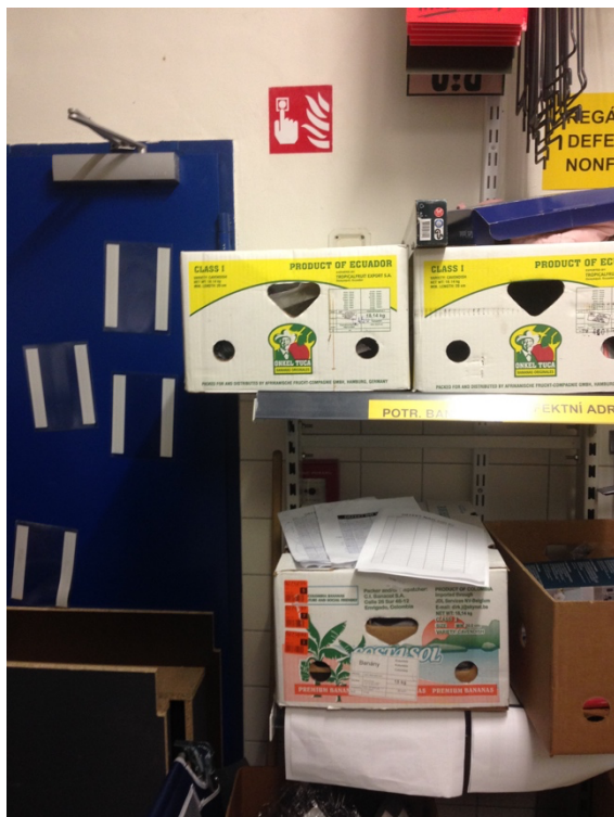
Obrázek 11 - Zastavěný přístup k tlačítkovému hlásiči EPS [zdroj vlastní]
