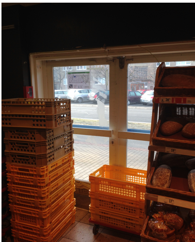
Obrázek 4 - uzamčený a zastavěný únikový východ [zdroj vlastní]
