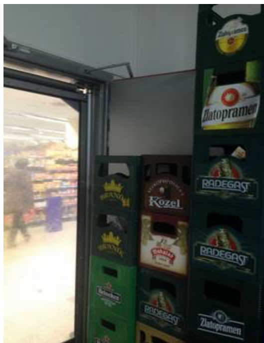
Obrázek 6 - Boční pohled, blokace požárních uzávěrů [zdroj vlastní]
