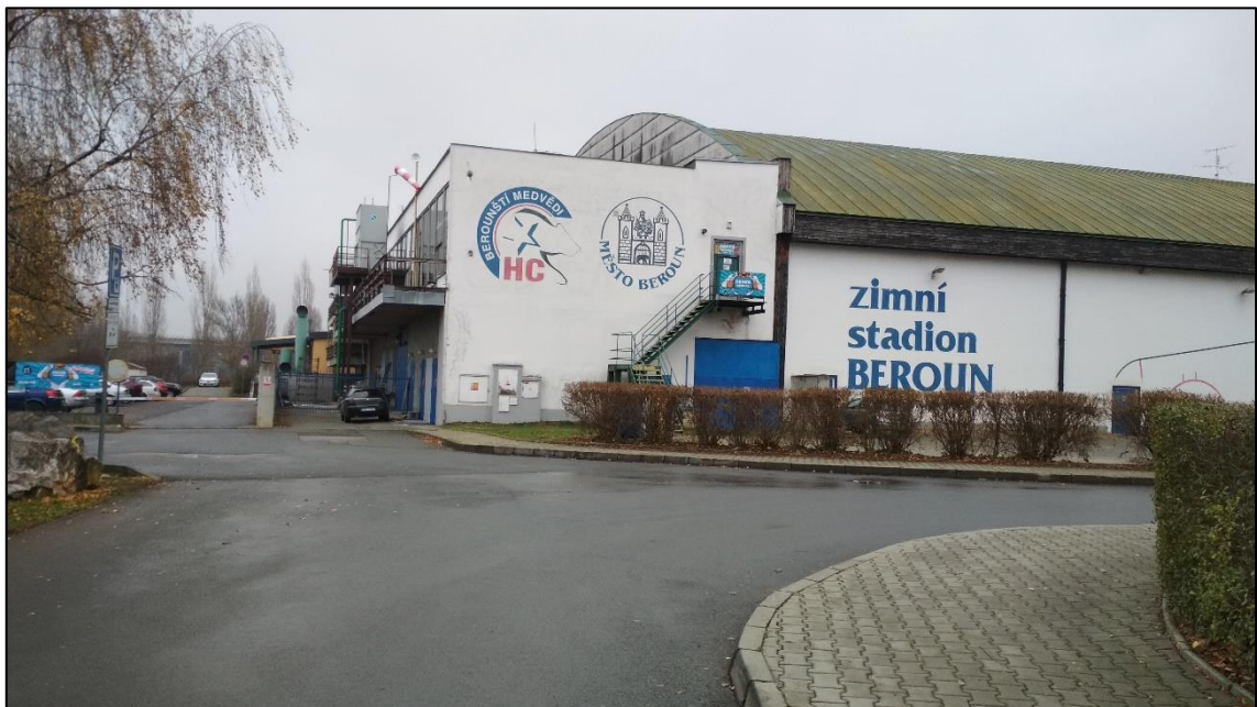
Obrázek 3 Zimní stadion Beroun - pohled na strojovnu z parkoviště (zdroj vlastní)
