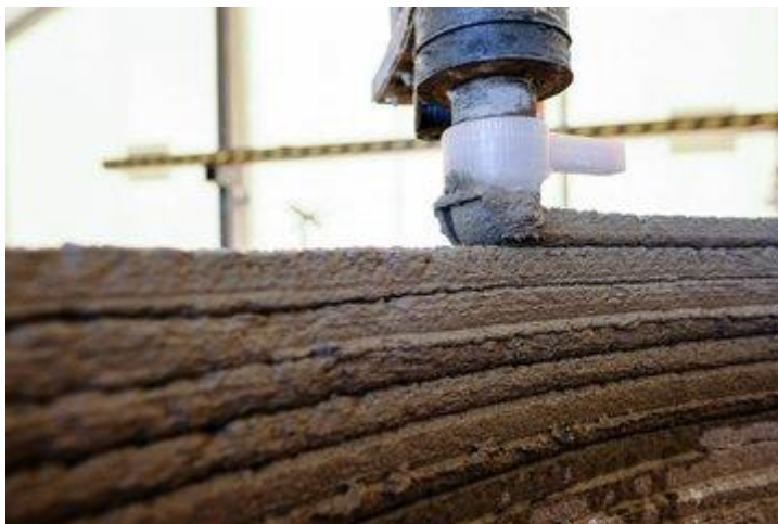
Obr. 4: Pokládání vrstvy betonové směsi při tisku budovy. Zdroj: [3]
