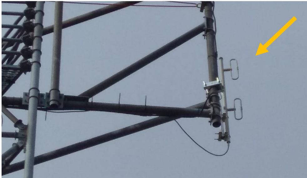
Obrázek 22 Anténa ATT Plus OV401.2 - montáž, při které je zadní lalok směřován do konstrukce stožáru Zdroj: vlastní
