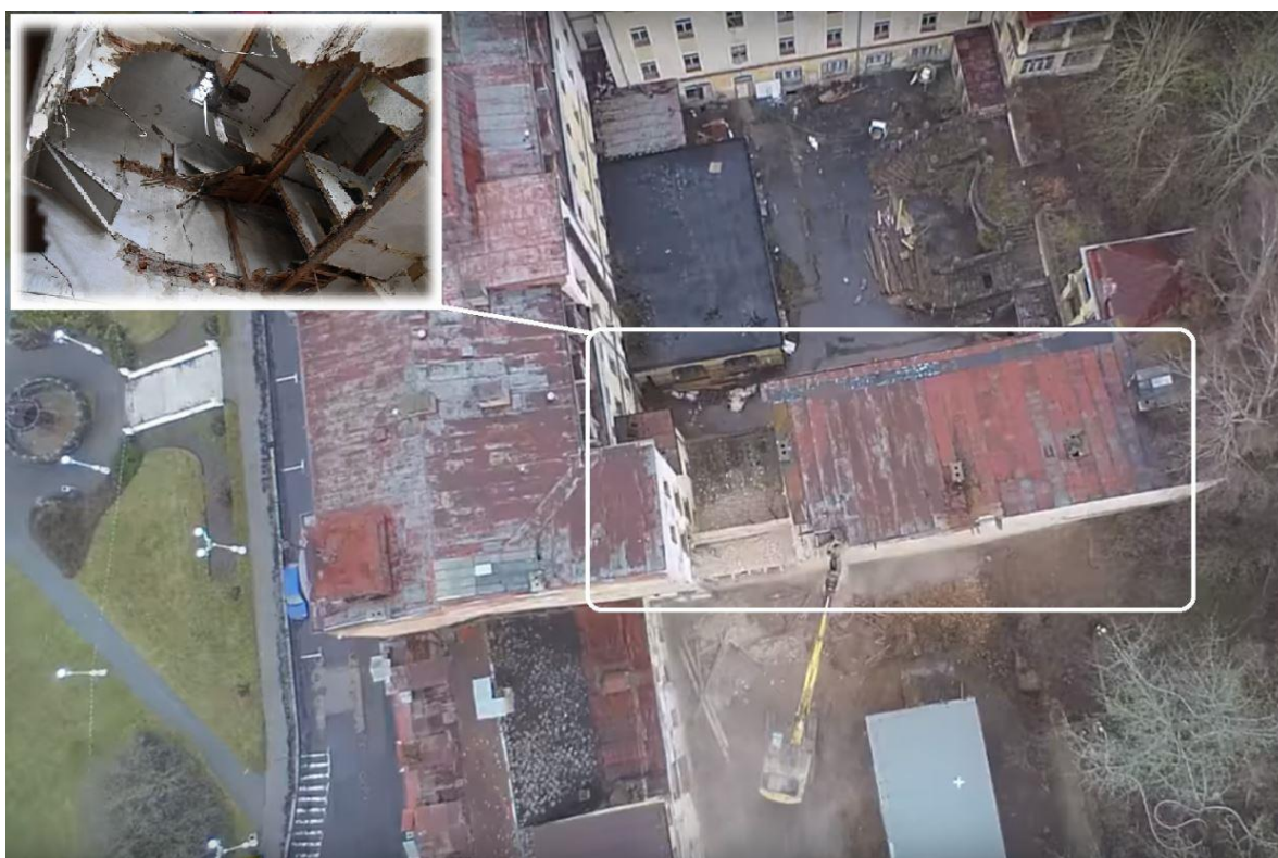
Obrázek 17 - Demolice budovy bývalého hotelu Kavkaz [archiv HZS KVK]
