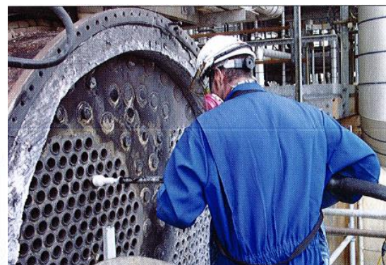
Obr. 20 Princip čištění tekutým dusíkem a ukázka čištění výměníku tímto zařízením [52].
