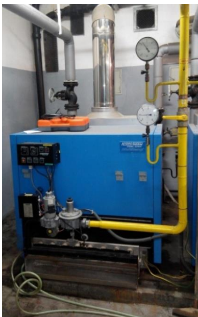
Obr. 37 Fotografie čištěného kotle [1A, 12A].
