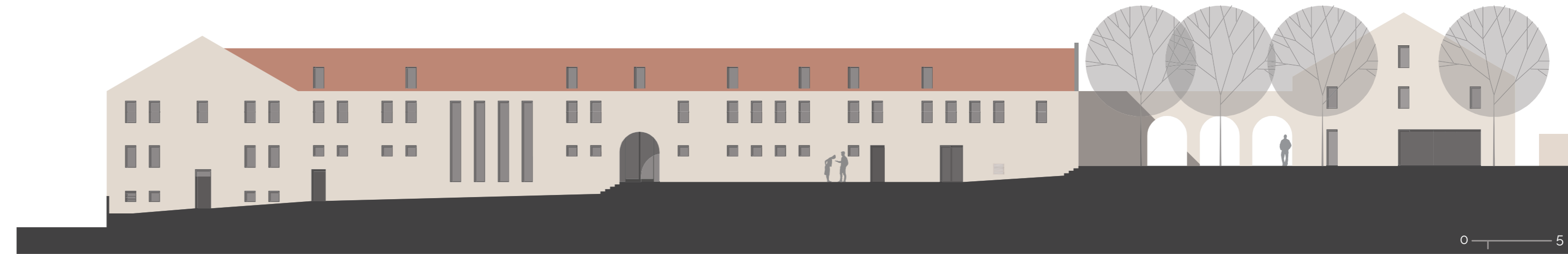
POHLED OD SEVEROVÝCHODU
