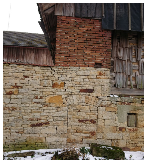
Severní stěna maštalé a kamenice
