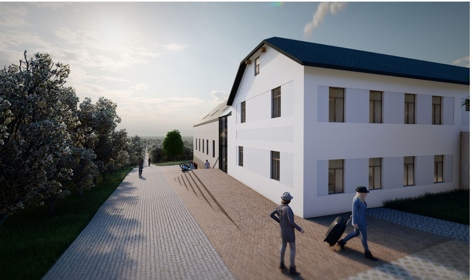
Pohled na hlavní vstup
