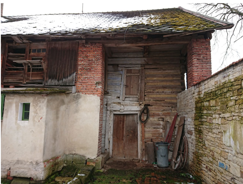
Vstup do maštale.
