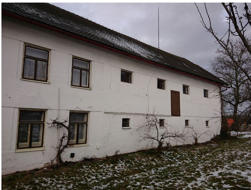
Zemědělská část hlavního objektu se seníkem a stájemi v 1.NP. Strop stájí je klenutý zděný ve válcovaných ocelových profilech.
