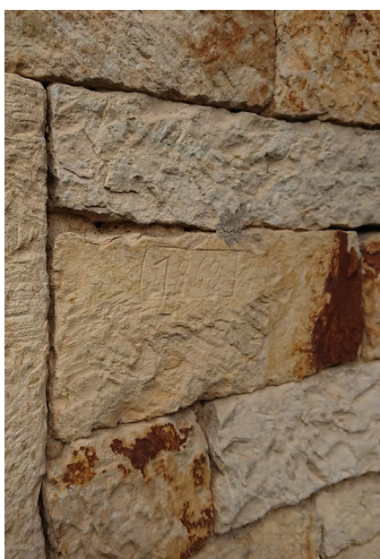
Provedení kamenného zdiva stodoly s vyrytým letopočtem vzniku 1863
