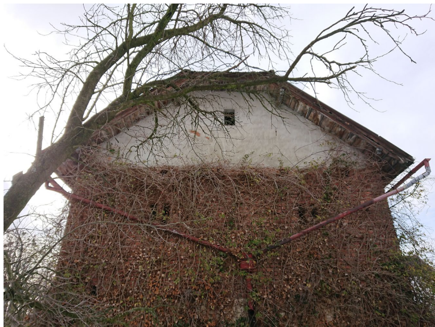
Východní stěna zemědělské části.
