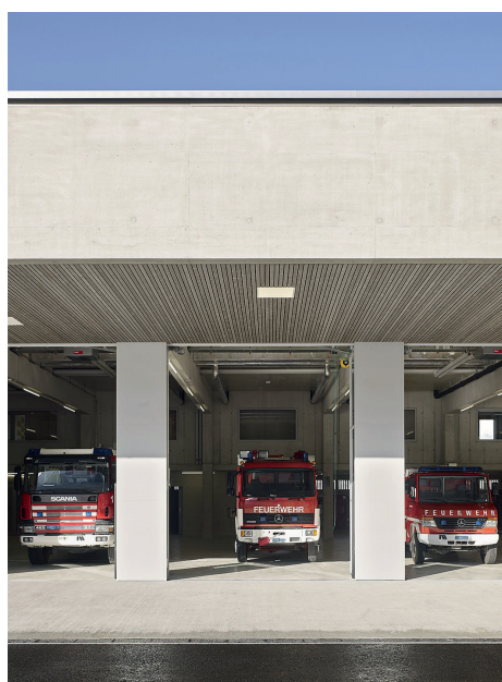
Garáže zásahových vozů jsou opatřeny vysokorychlostními průmyslovými vraty. Nabízejí se různé možnosti otevírání - skládání k jedné straně, skládání od středu do stran, vrata sekční či výklopná.
