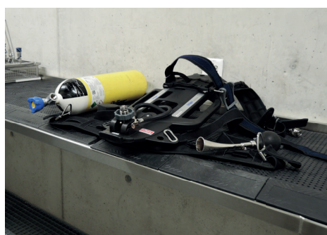
Stanice Götzis - tunel pro mytí hadic a místnost pro údržbu dýchacích přístrojů s mycí linkou a pultem pro plnění a kontrolu vzduchotěsnosti.
