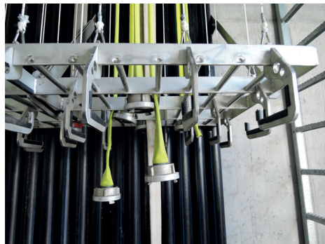
Skladování hadic a výtah pro vyvezení hadic do věže na sušení ve stanici obce Hohenweiler v Rakousku.
