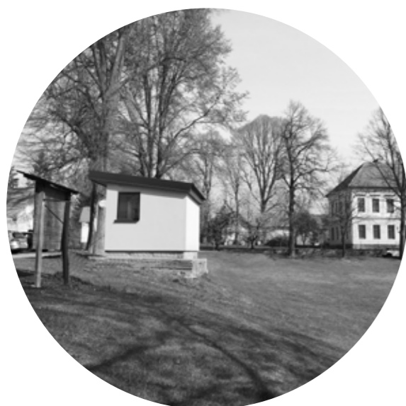
po odstranění prvků
