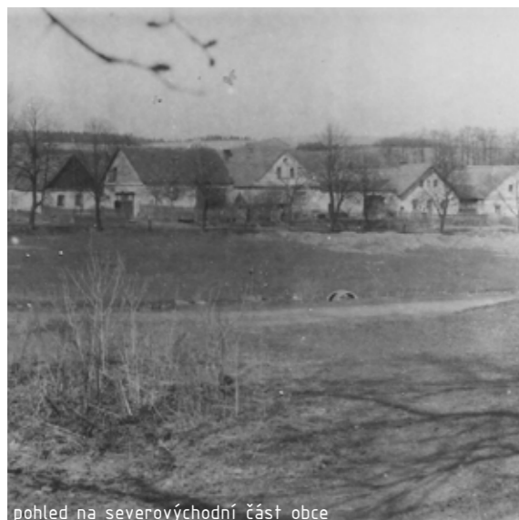
pohled na severovýchodní část obce
