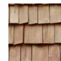
Šindelová střešní krytina
