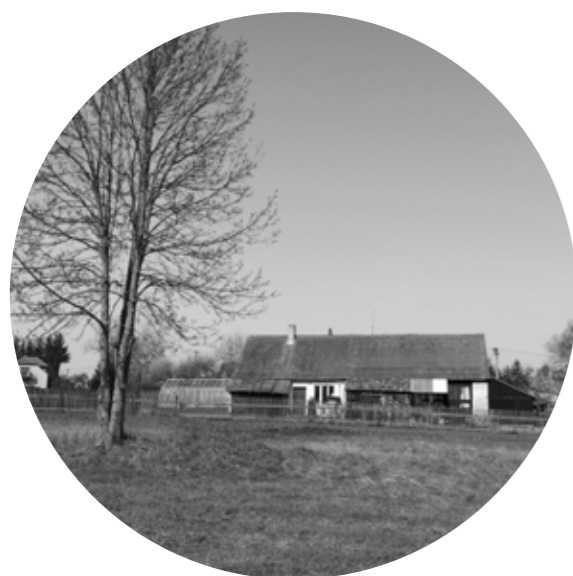
po odstranění prvků
