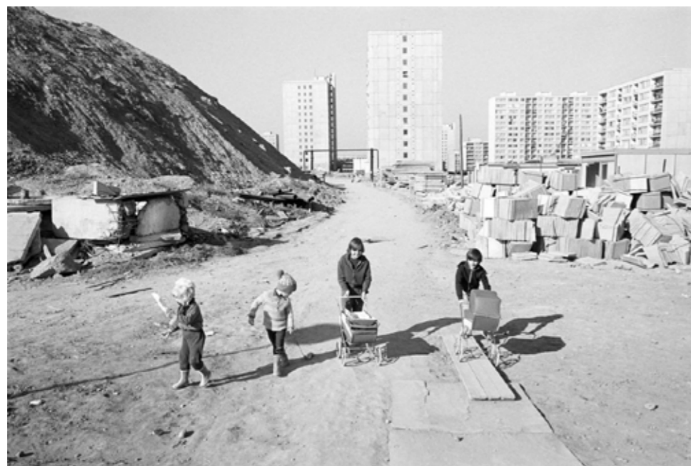
Panelstory Jižního Města v 80. letech - Jaromír Čejka
