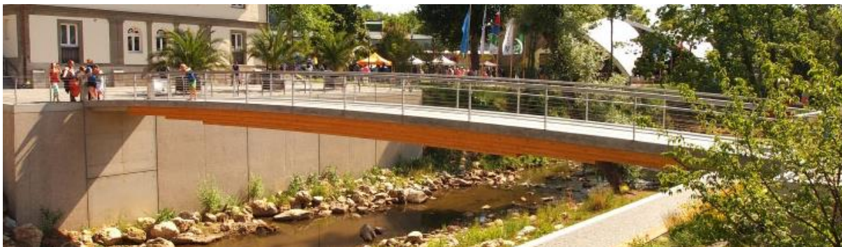
Obr. 8: Pohled na rámový spřažený most ve Schwäbisch Gmünd, zdroj [8]
