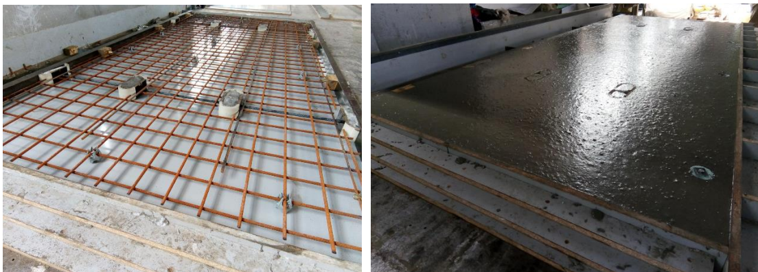
Obr. 71: Vlevo pohled do bedněni před betonáží panelu typ N, vpravo panel typ K těsně po betonáží
