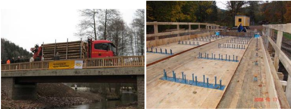
Obr. 5: Mostu přes řeku Wipper - zatěžovací zkouška a pohled do bednění [28]
