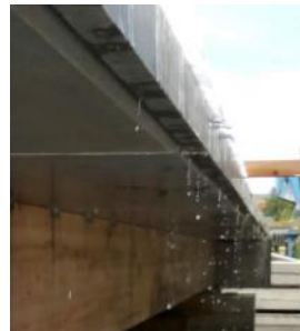
Obr. 74: Vlevo pohled na mostovku po aplikaci zálivky do otvorů, vpravo detail okapničky s odkapávající vodou během ošetřování zálivky
