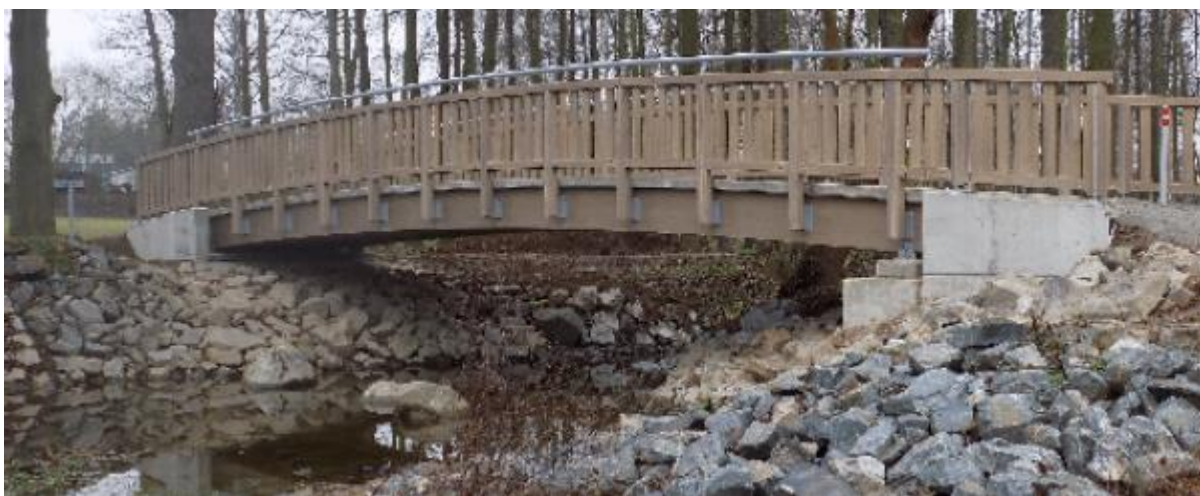
Obr. 9: Lávka přes Benešovský potok v Benešově [10]
