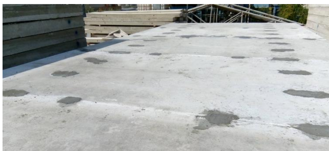
Obr. 74: Vlevo pohled na mostovku po aplikaci zálivky do otvorů, vpravo detail okapničky s odkapávající vodou během ošetřování zálivky
