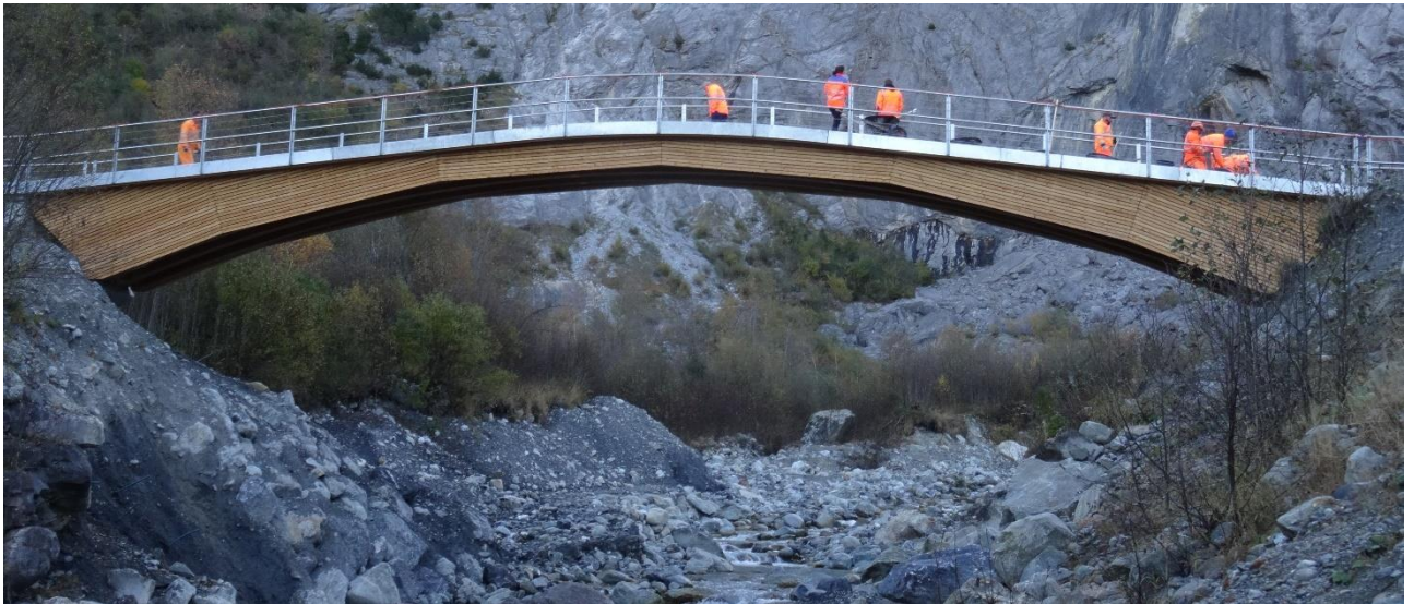
Obr. 10: Spřažená dřevo-UHPC lávka Gletschersand ve Švýcarsku, projekt Emch+Berger Ingenieure AG Bern (M.-A. Berchtold und A.Hemmi), expert prof. E. Brühwiler, foto poskytl prof. E. Brühwiler
