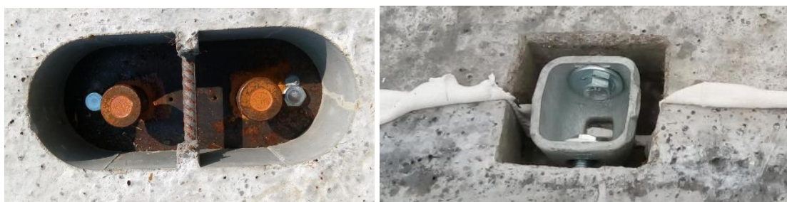
Obr. 73: Vlevo otvor po uložení panelu na spřahovací prvky, vpravo dotažený šroubový spoj panelů po aplikaci epoxidového lepidla do spáry
