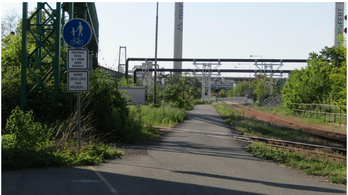
Obrázek 17 Společná stezka pro cyklisty a chodce propojující ulice Tovačovská – nábř. Dr. Edvarda Beneše přes řeku Bečvu
