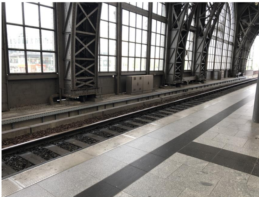
Obrázek 15 – Nástupiště Dresden Hauptbahnhof [autor]
