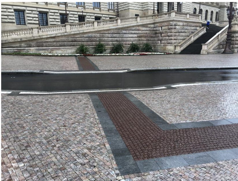
Obrázek 9 – Správně řešené místo pro přecházení, Praha [autor]
