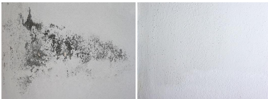
Obr. 61 Fotografie stěny s nárůstem plísní před aplikací (vlevo) a po aplikaci P. oligandrum (vpravo)
