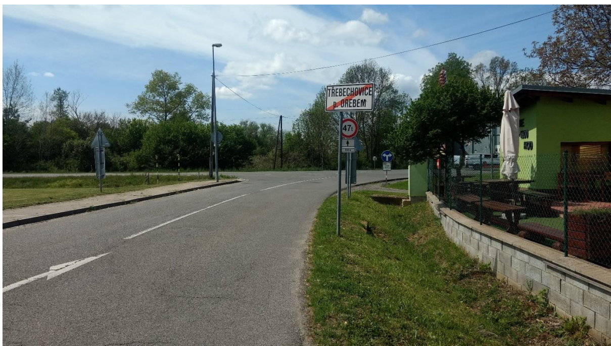
Obr.č.19 – Pohled na křižovatku směrem od Třebechovic pod Orebem
