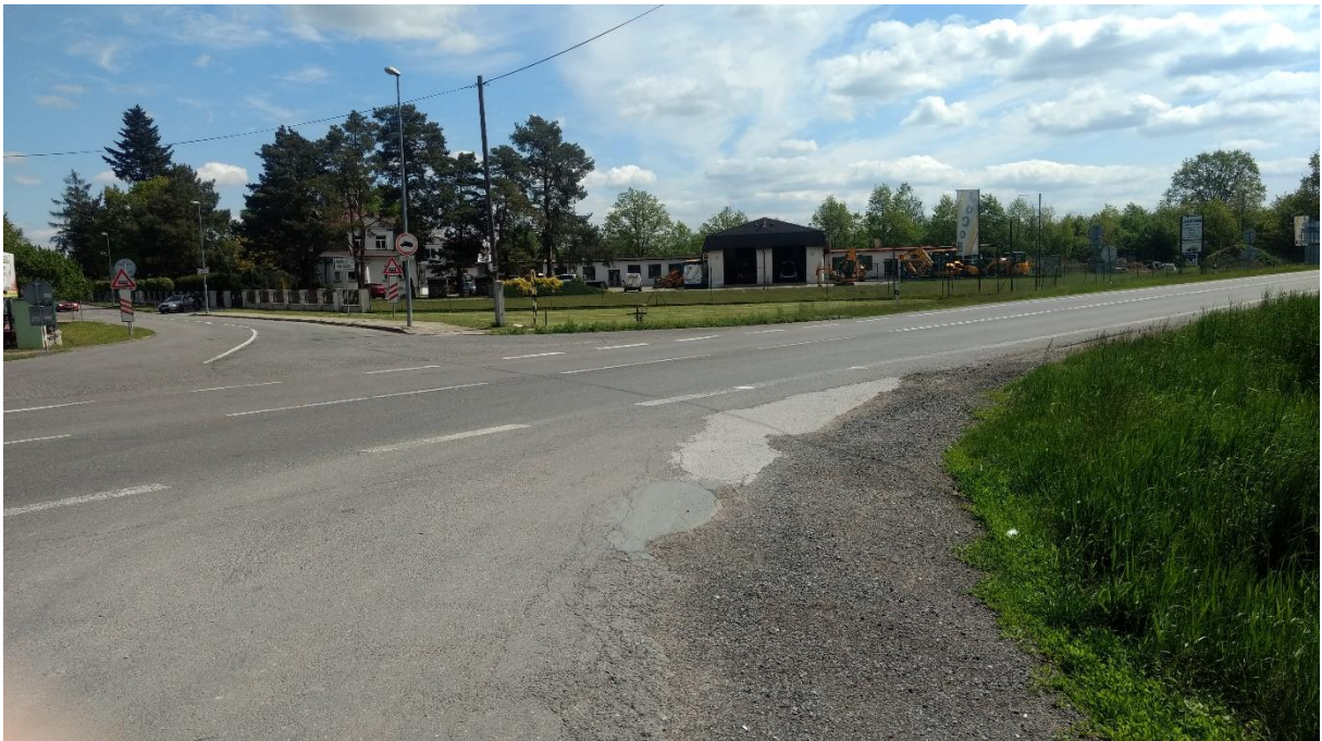
Obr.č.22 – Pohled na prudký zlom ramene těsně před křižovatkou
