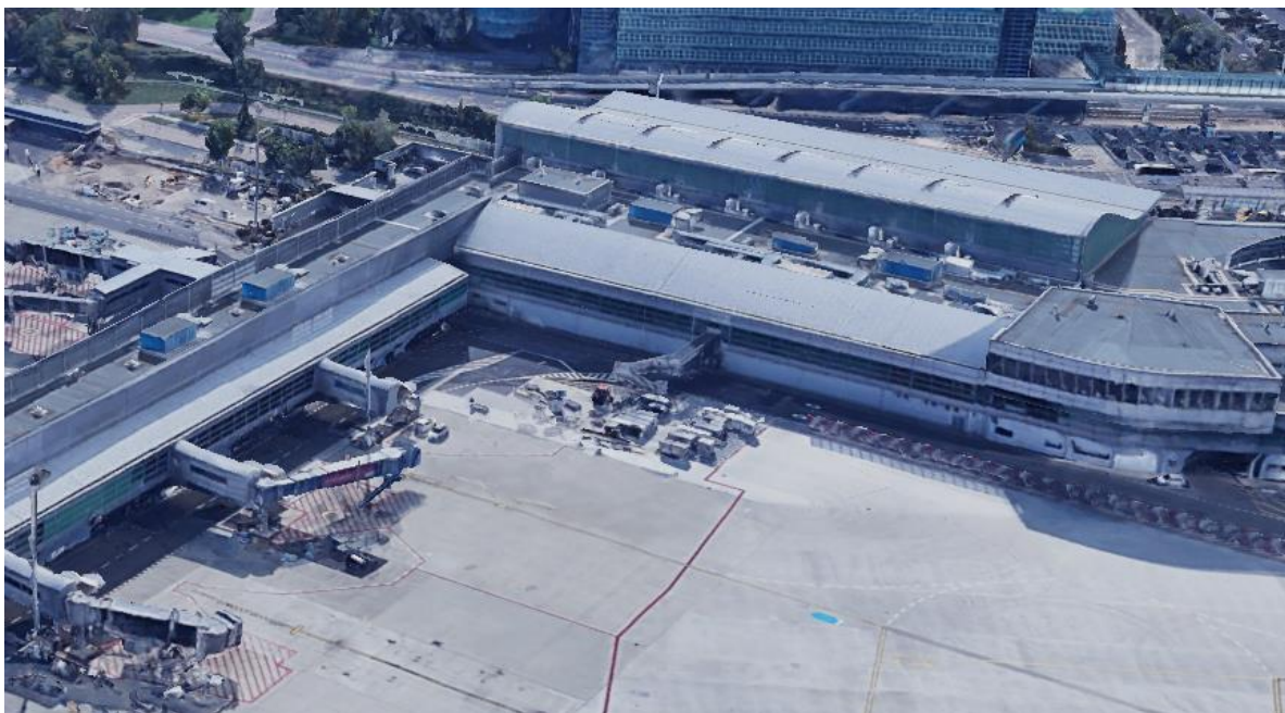
Obrázek 13 - Skladovací prostory pro ULD na LKPR (Zdroj: earth.google.com)
