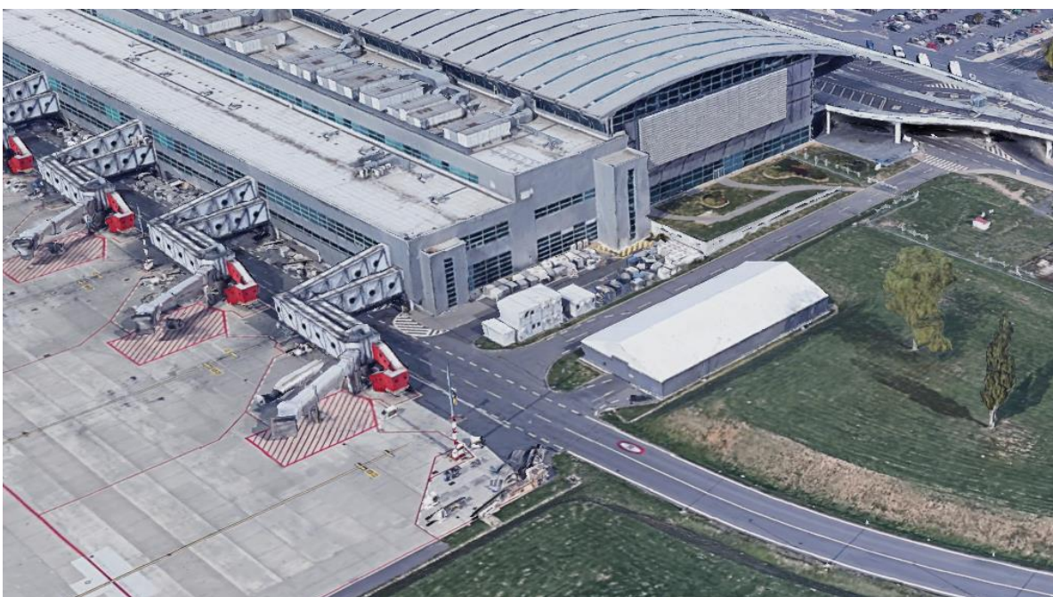
Obrázek 14 - Skladovací prostory pro ULD na LKPR (Zdroj: earth.google.com)
