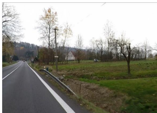
Obrázek 32 - Krátké svodidlo u příčného propustku. LK (ID 7044)
