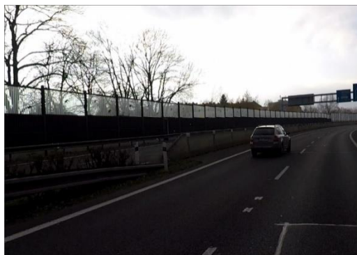
Obrázek 28 - Neadekválně realizovaný přechod mezi různými druhy svodidel. LK (ID 3202)
