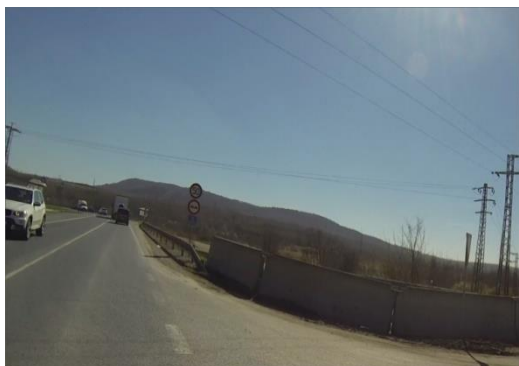
Obrázek 27 - Neadekválně realizovaný přechod mezi různými druhy svodidel. UK (ID 8130)
