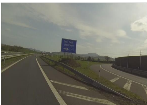
Obrázek 33 - Neopodstatněně umístěné svodidlo. KV (ID 539)
