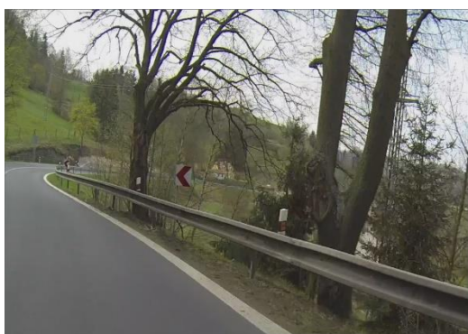
Obrázek 17 - Nedodržení min. vzdálenosti 1,0 m za svodidlem. KV (ID 1333)
