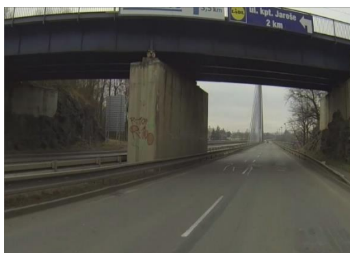
Obrázek 18 - Nedodržení min. vzdálenosti 1,0 m za svodidlem. JK (ID 8226)
