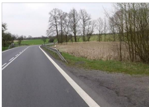
Obrázek 26 - Krátké svodidlo před - místem nebezpečí. PLZ (ID 1373)
