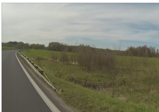
Obrázek 25 - Krátké svodidlo před – místem Nebezpečí. KV (ID 279)
