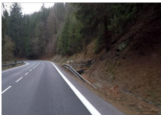
Obrázek 31 - Krátké svodidlo u příčného propustku LK (ID 5288)
