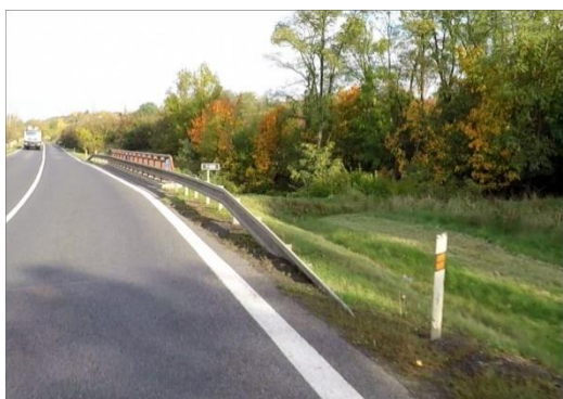
Obrázek 29 - Krátké svodidlo před – mostem. SCK (ID 12111)
