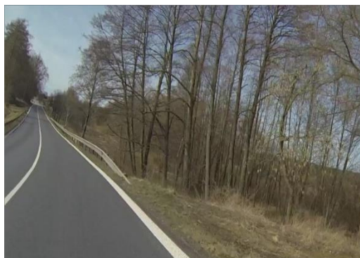
Obrázek 24 - Krátké svodidlo před – stromem. JK (ID 10914)
