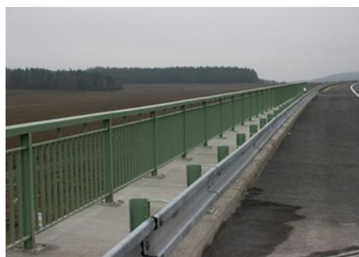
Obrázek 5 - Zábradlí na mostě. [16]
