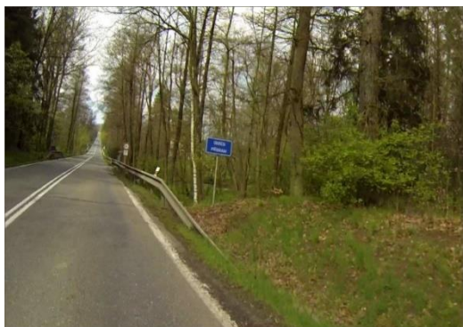
Obrázek 23 - Krátké svodidlo před – stromem. SCK (ID 6975)
