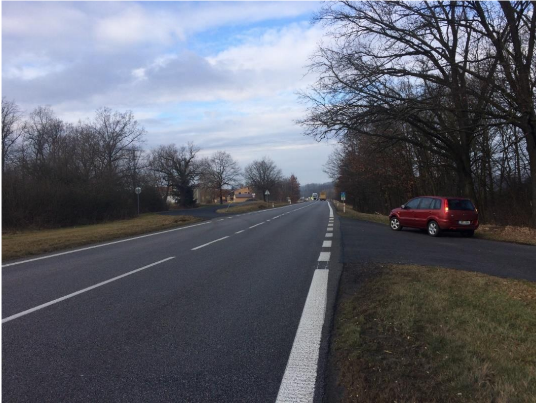
Obrázek 17 – Pohled na křižovatku „B“ z hlavního ramene křižovatky „B“ - silnice I/20 – směr ČB – Písek [zdroj: archiv autora, 2020]
