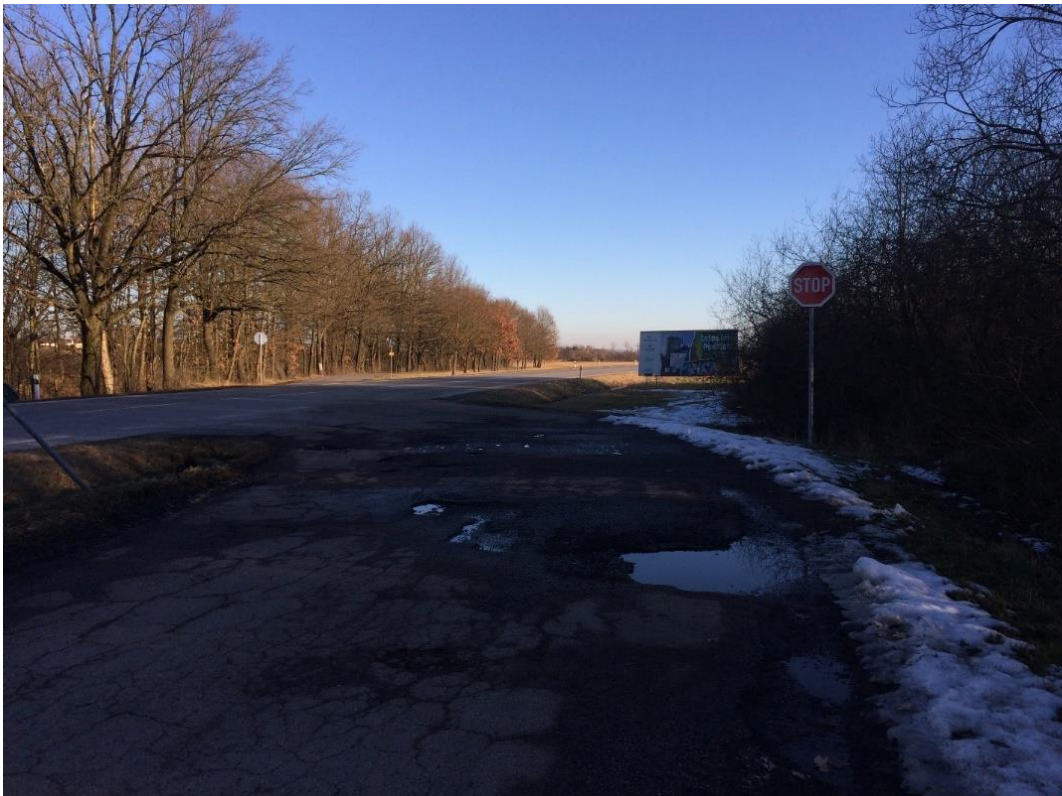
Obrázek 14 – Pohled na křižovatku „B“ z vedlejšího ramene křižovatky „B“ před úpravou povrchu – MK [zdroj: archiv autora, 2019]
