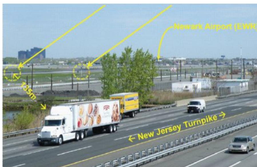
Obrázek 7: Dálnice vedle airfieldu na letišti v Newarku. [34]
