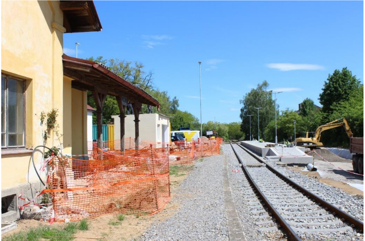
Obrázek 9: Dopravna D3 Bělčice ve výstavbě poloostrovního nástupiště ze dne 29.5.2020
