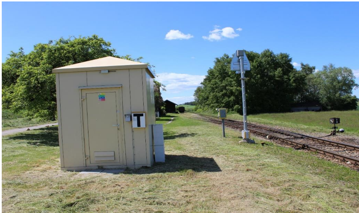
Obrázek 15: Dopravna D3 Sedlice pohled směr Blatná od přejezdu v km 30,829
