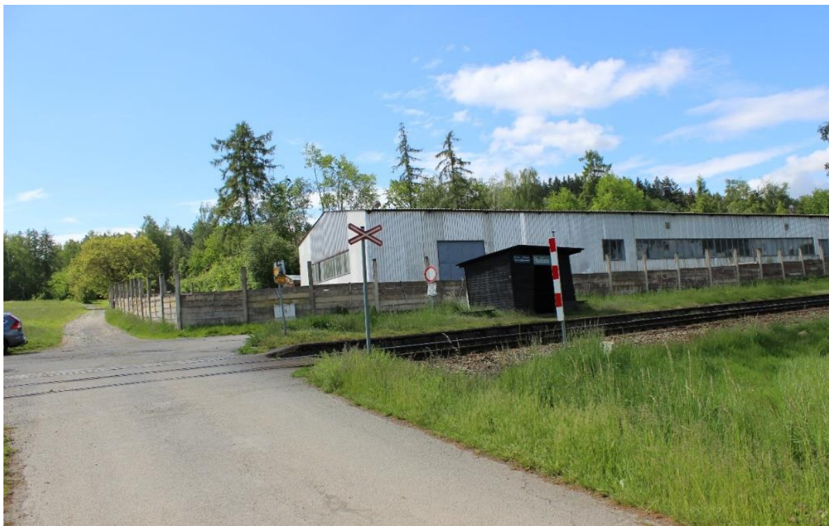
Obrázek 6: Pohled na zastávku Hudčice a příjezdovou cestu od obce Hudčice
