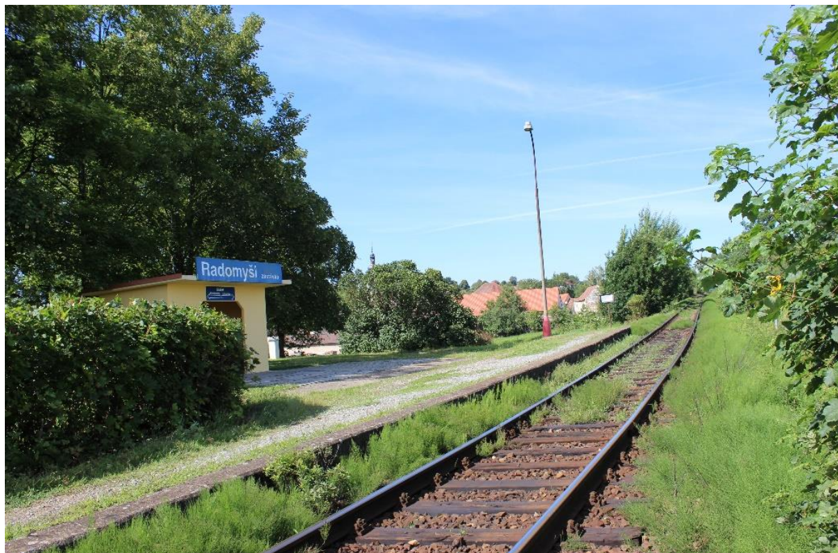
Obrázek 20: Pohled na zastávku Radomyšl zastávka směr Blatná
