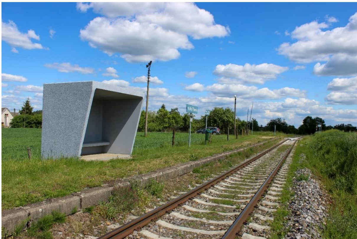
Obrázek 18: Zastávka Velká Turná pohled směr Strakonice
