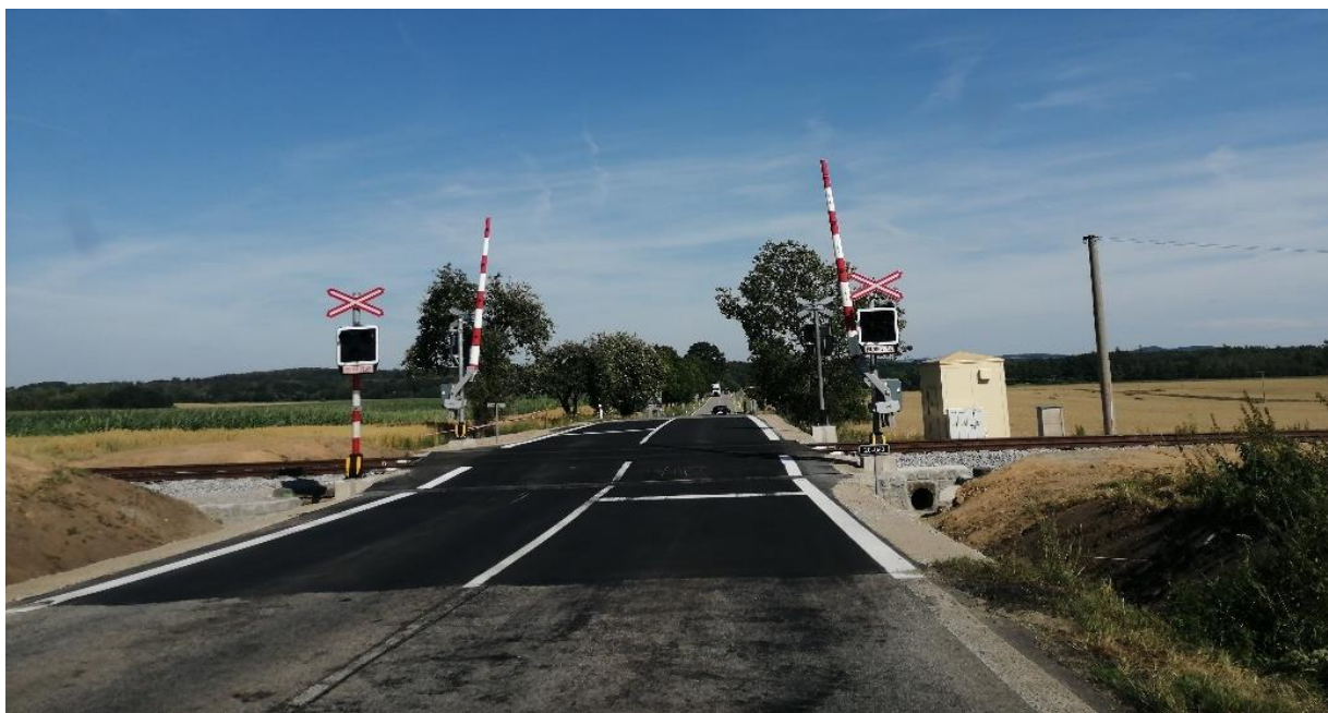
Obrázek 4: Železniční přejezd v km 33,149 s moderními závorovými břevely
