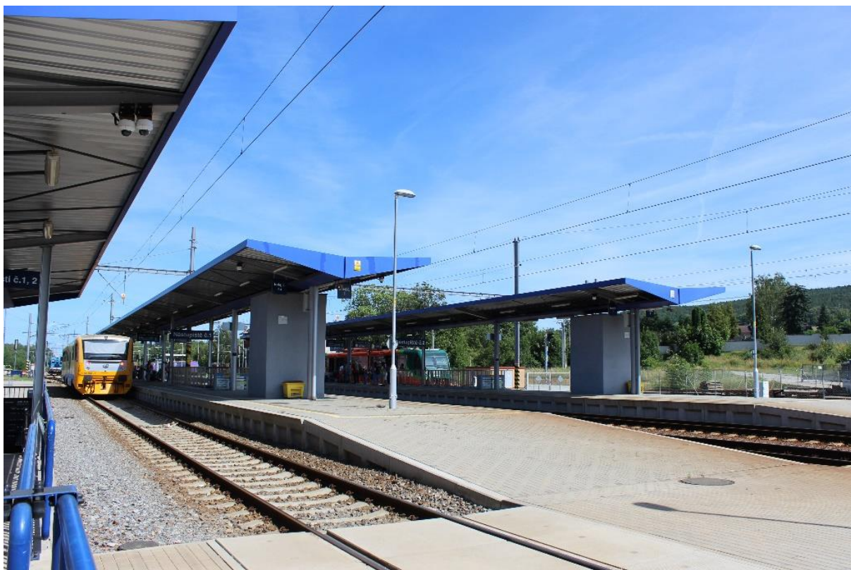
Obrázek 24: ŽST Strakonice pohled na nástupiště směr Blatná
