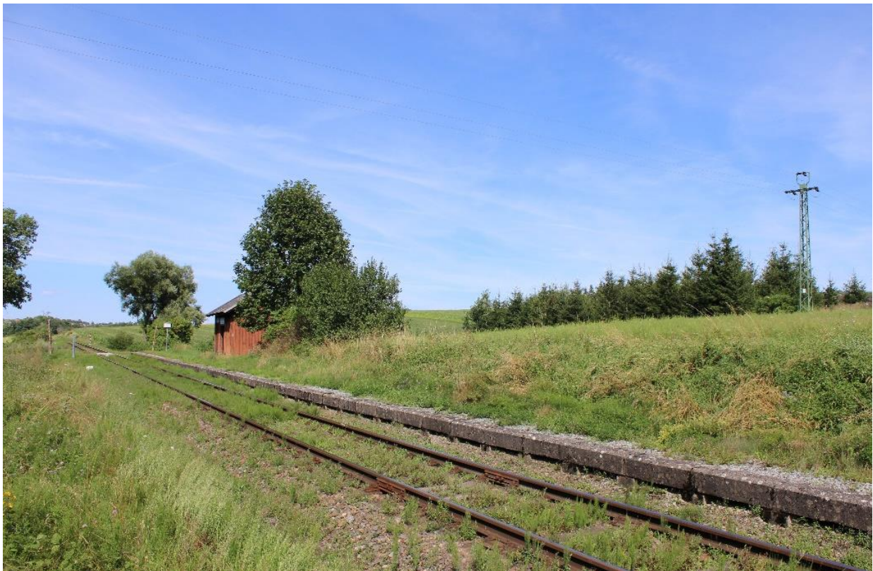
Obrázek 21: Zastávka Domanice z pohledu od Strakonic
