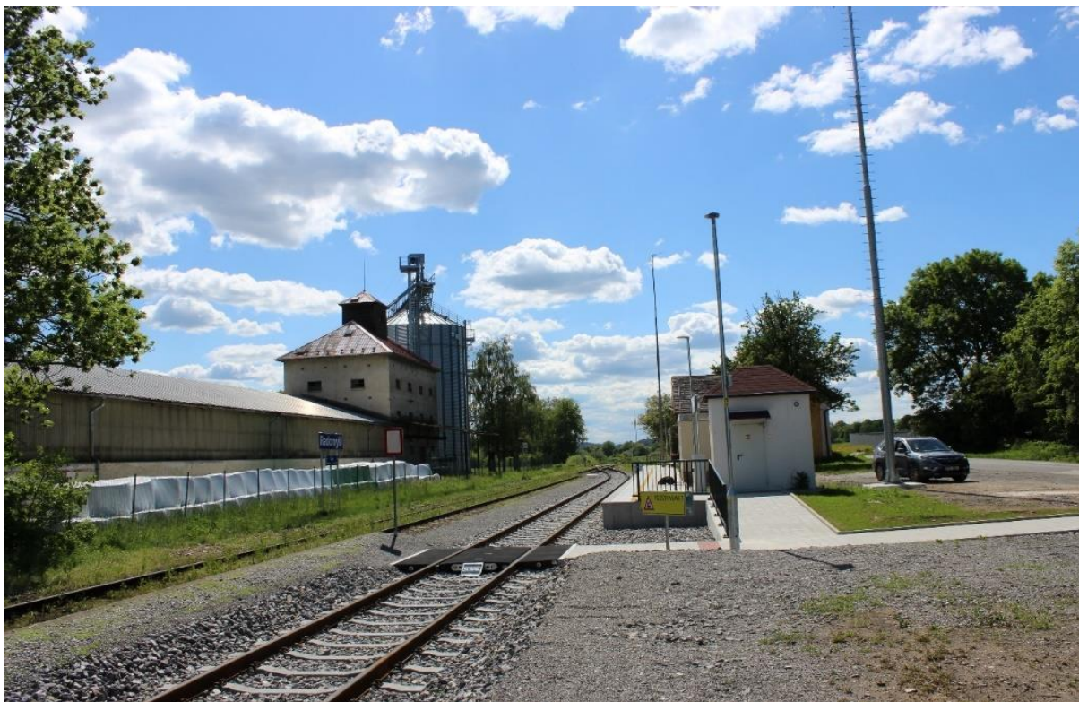
Obrázek 19: Pohled na nástupiště v dopravně D3 Radomyšl směr Strakonice
