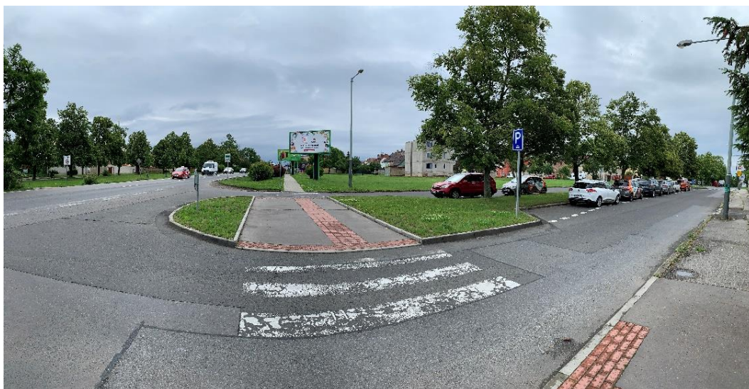
Obrázek 25 Tramvajová trať odbočuje z ulice Karlovarská do ulice Na Bělohorské pláni
