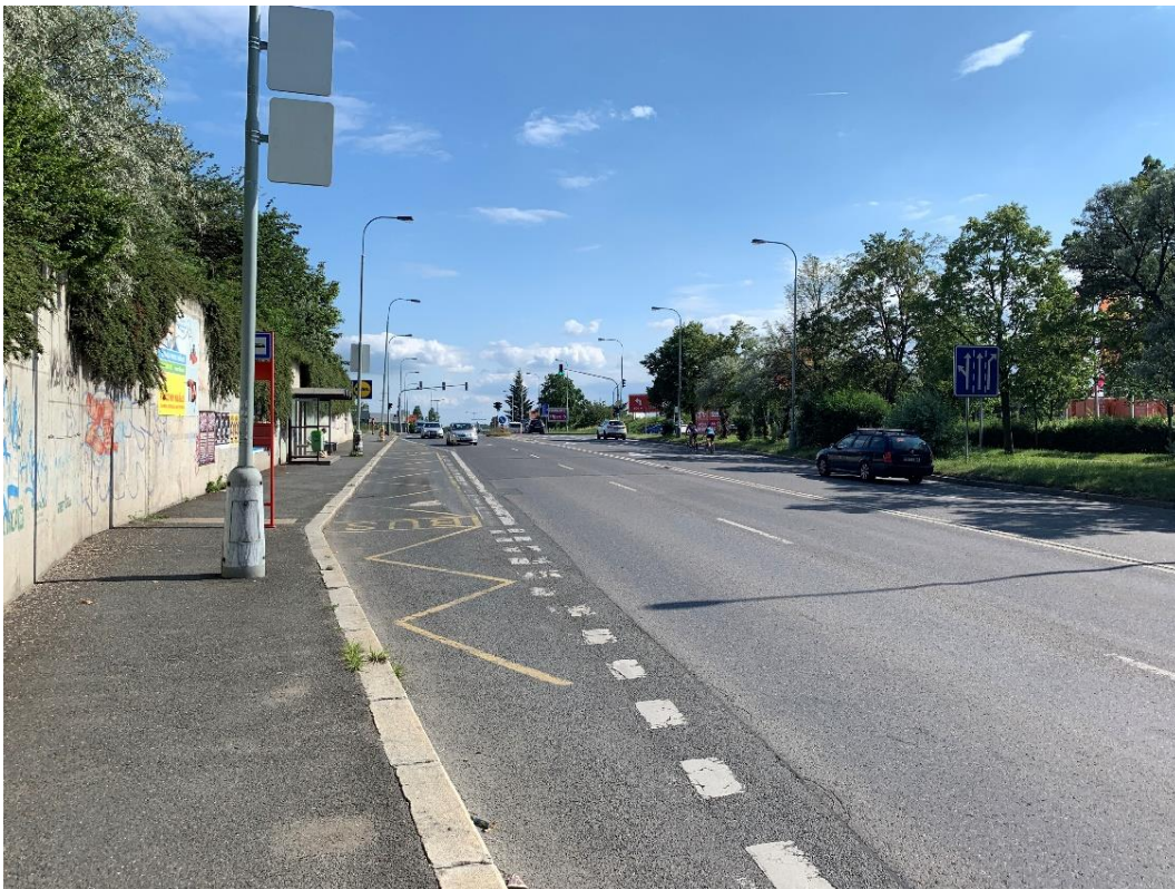
Obrázek 21 Pohled na autobusovou zastávku Reinerova od křižovatky ulic Karlovarská x Slánská
