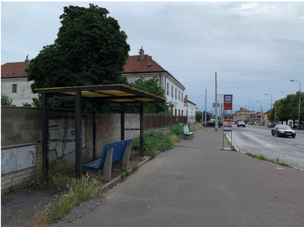
Obrázek 13 Zastávkové stanoviště na ulici Karlovarská směr Ruzyňský hřbitov
