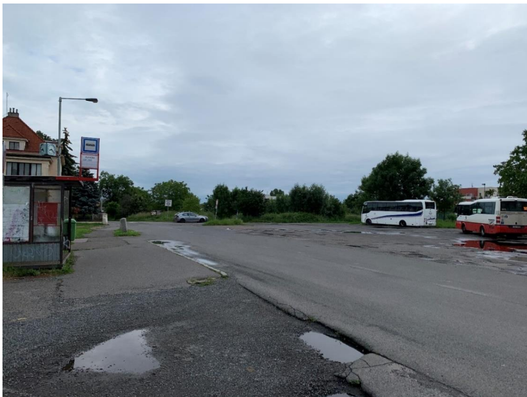
Obrázek 9 Pohled na odstavnou plochu autobusů a nástupní zastávkové stanoviště na ulici Zličínská
