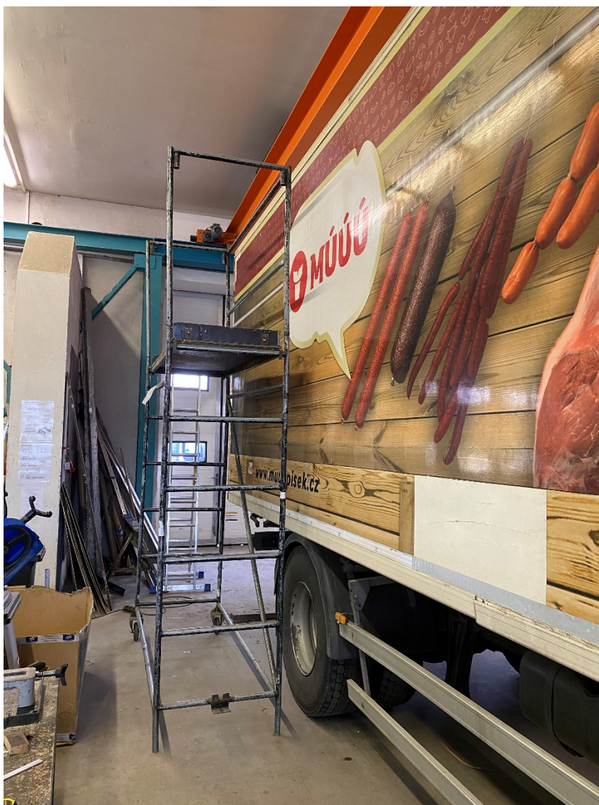
Obrázek 15: Stará konstrukce lešení [Vlastní foto]
