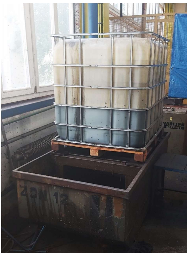
Obr. 8 - IBC kontejner pro skladování odpadních olejů zdroj: autor
