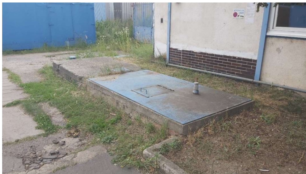
Obr. 6 - Jímka pro skladování odpadních emulzí, zdroj: autor
