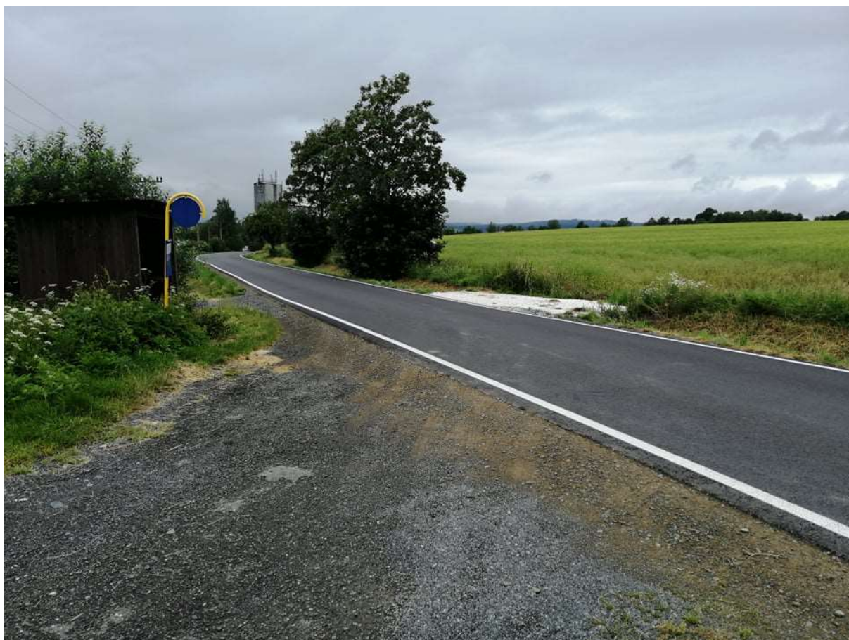
Obr. 19 – Pohled na zastávku Nový Dvůr směrem na Rožmitál, zdroj: vlastní produkce autora
