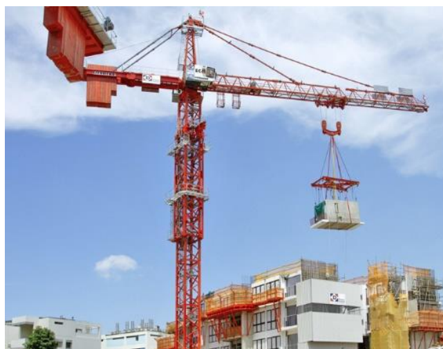
Obrázek 1 Jeřáb při stavbě [2]
