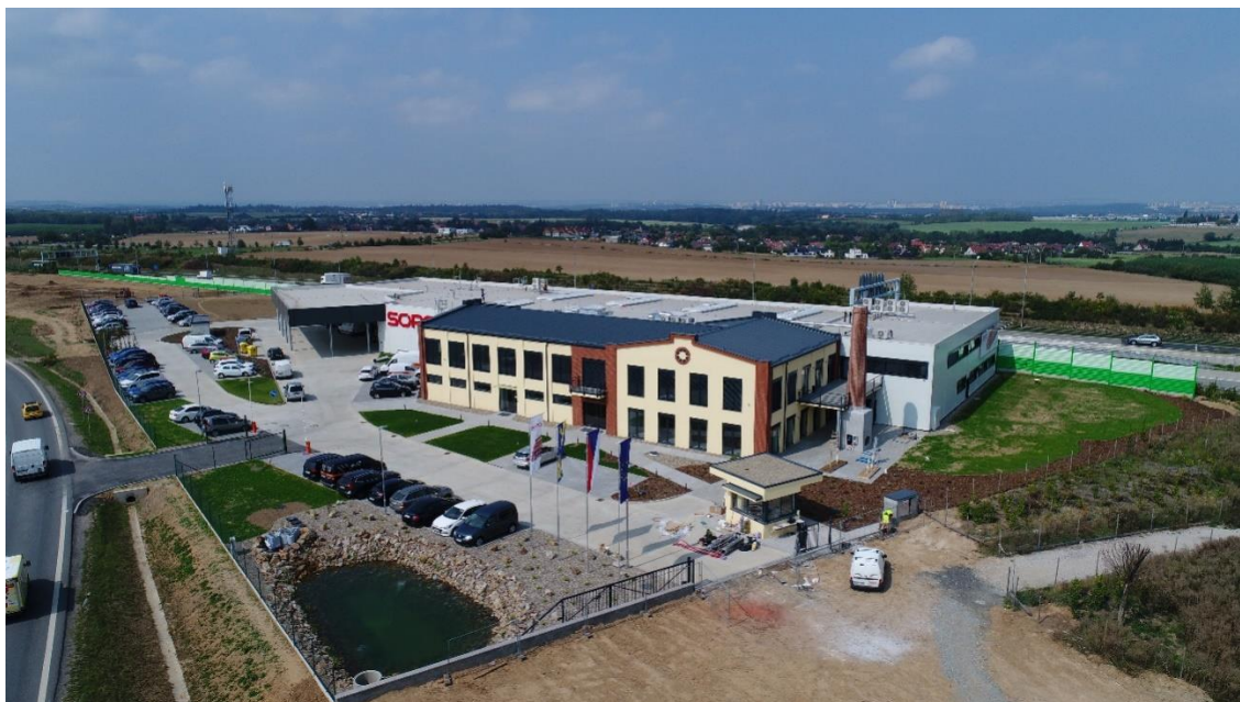
Obr. 32 - Nová výrobní hala SOPO, s.r.o. a sídlo firmy [35]
