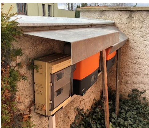
Obrázek 8.3 Umístění střídačů na FVE3
