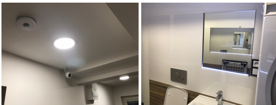
Obrázek 2.5: V prádelně jsou hlavním osvětlením zapuštěné kulaté panely. Panely jsou prodávány pro připojení na síťové napětí 230 V, nicméně jsem v nich provedl výměnu za LED pásku (teplota 4.000 - 4.500 K, denní bílá, CRI>90%), která mi umožnila napojení světla na Loxone RGBW extension a tedy plynulé rozsvícení a zhasínání. Zrcadla jsou stejně jako ve všech ostatních místnostech podsvícena.
