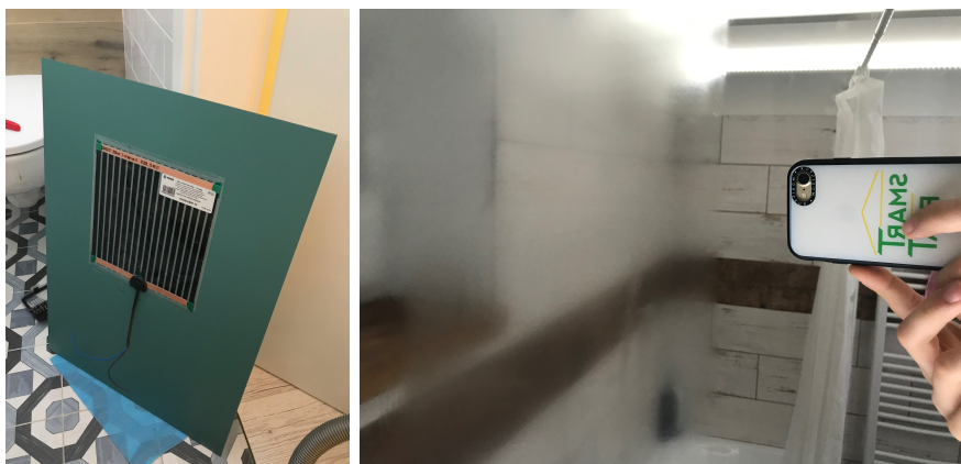
Obrázek 4.9: Topná folie na zadní straně zrcadla proti mlžení
