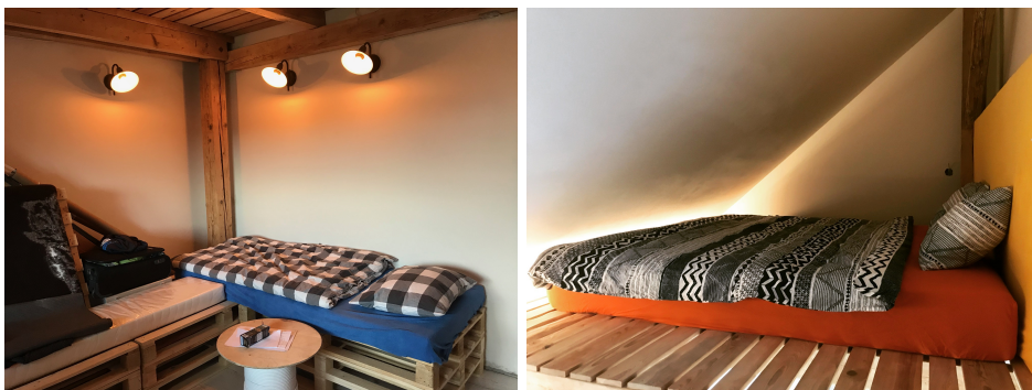
Obrázek 2.4: V pokoji M3 je osvětlení rozděleno na spodní a horní část. V horní části se nachází spaní a osvětlení je zajištěno LED páskem (teplota 3.000 K, teplá bílá, CRI>90%) zapuštěným do nosného trámu patra. Dále je zde barevný RGBW LED pásek za trámem. Ve spodní části je osvětlení kombinované stmívanými bodovými světly a LED páskem na trámu.
