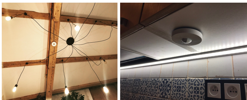
Obrázek 2.12: V kuchyni je osvětlení přímé s designovými žárovkami napojenými na Loxone Dimmer extension, který umožňuje plynulé rozsvícení, zhasínání a nastavení jasu. Osvětlení kuchyňské linky se zapne až ve chvíli, kdy se rukama začne pracovat na kuchyňské desce.
