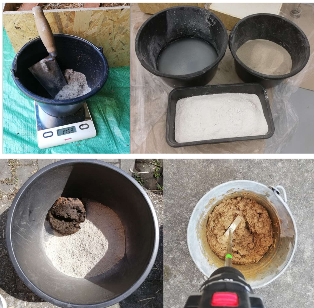
Obrázek 25 Příprava směsi na omítku
