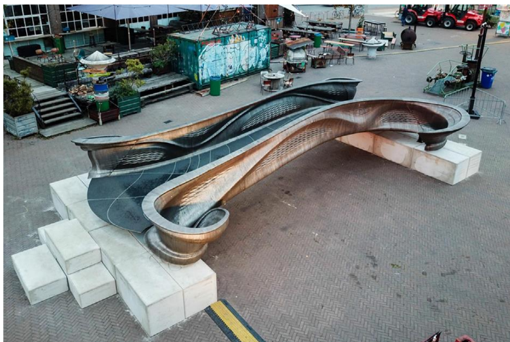
Obr. 7 - Kompletně vytištěný MX3D most [6]
