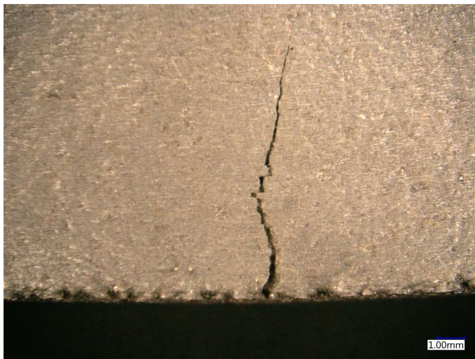
Obrázek 60 Trhlina vzorku 13_OT3
