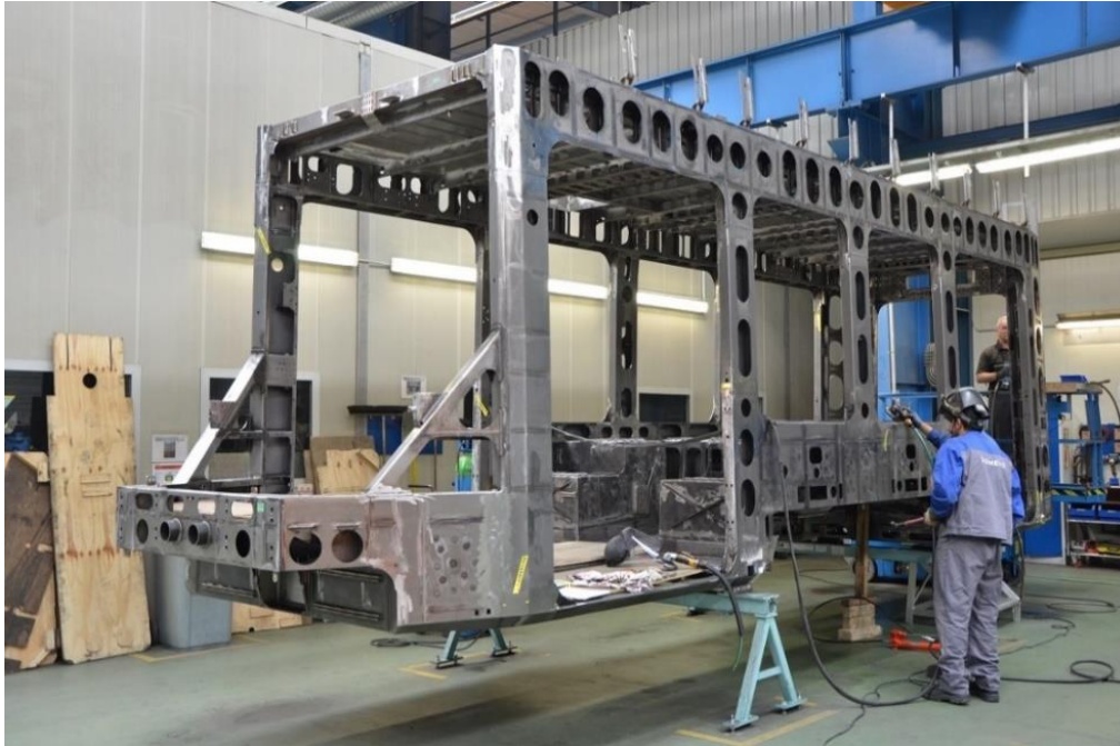
Obr. 41.: Hrubá stavba tramvaje Avenio [15]
