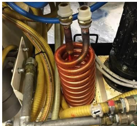
Obrázek 14 výměník při instalaci [11]
