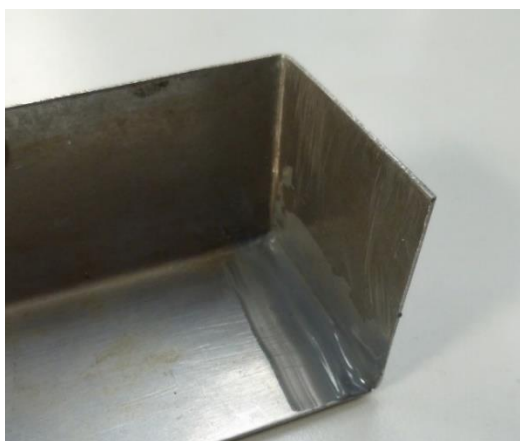
Obrázek 52 Detail rohu okapu a lepeného spoje
