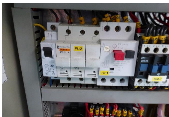
Obrázek 76 Instalovaný jistič digitálního odměřování (vlevo)
