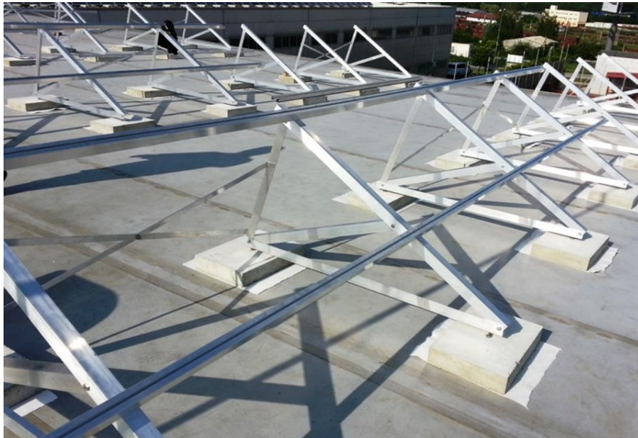
Obr. 3.3: Konstrukce solárních modulů. 26
