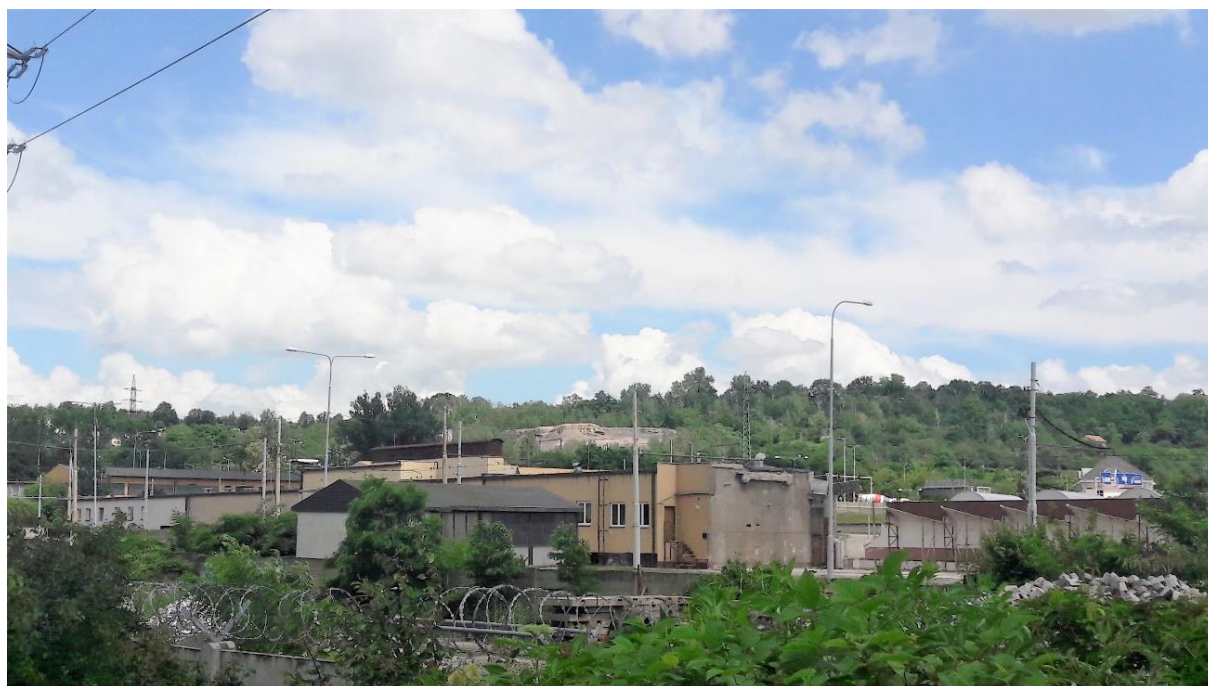
Obr. 24: Fotografie pohled do areálu vozovny Hloubětín
