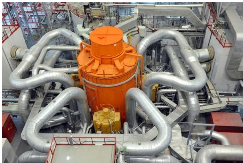
Obrázek č. 7: Reaktor BN-800. Na tomto obrázku jsou vidět 3 oddělené chladicí okruhy.[43]
