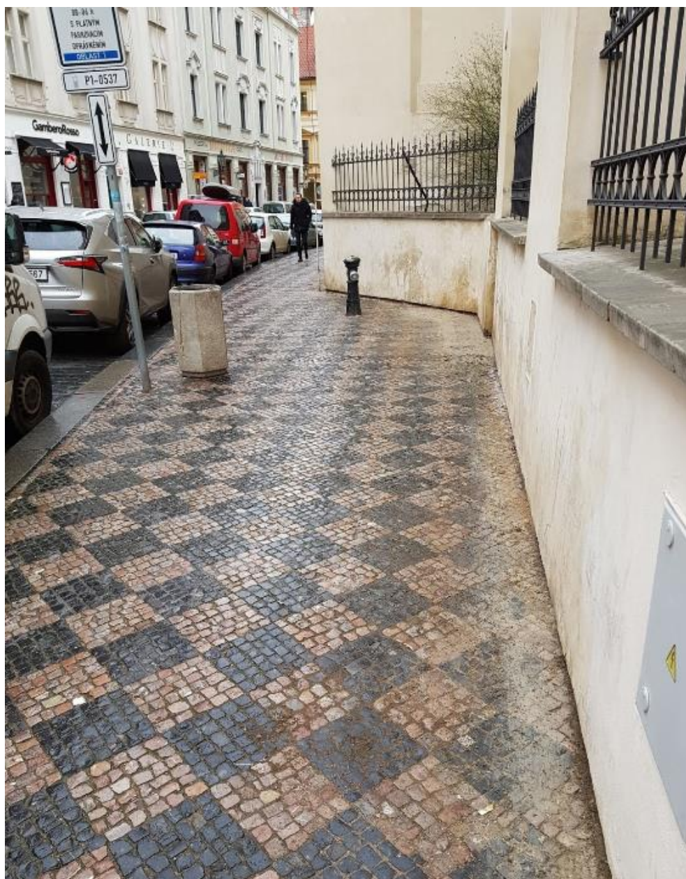
Obr. č. 10: realizovaná venkovní pokládká
