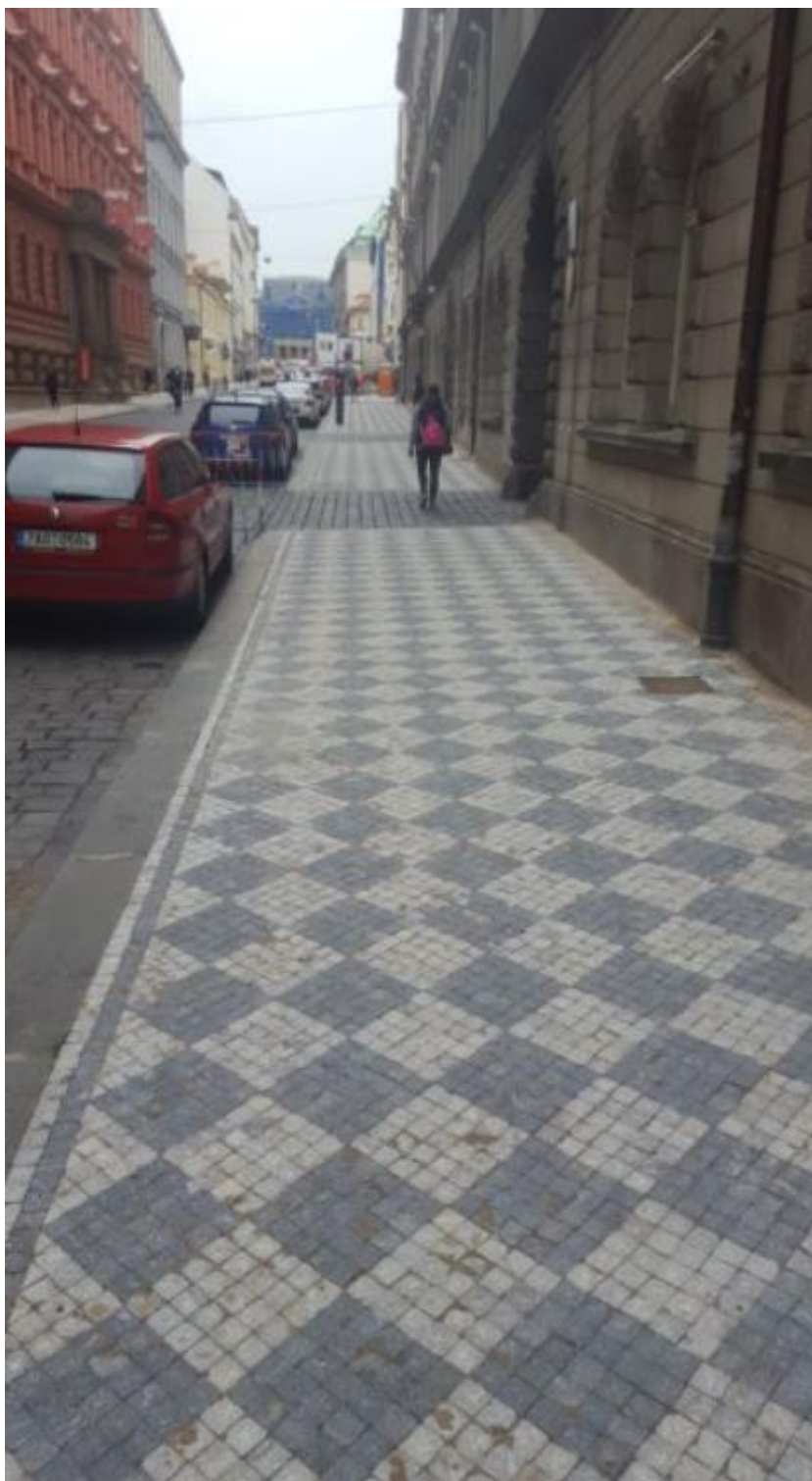
Obr. č. 16: realizovaná pokládka
