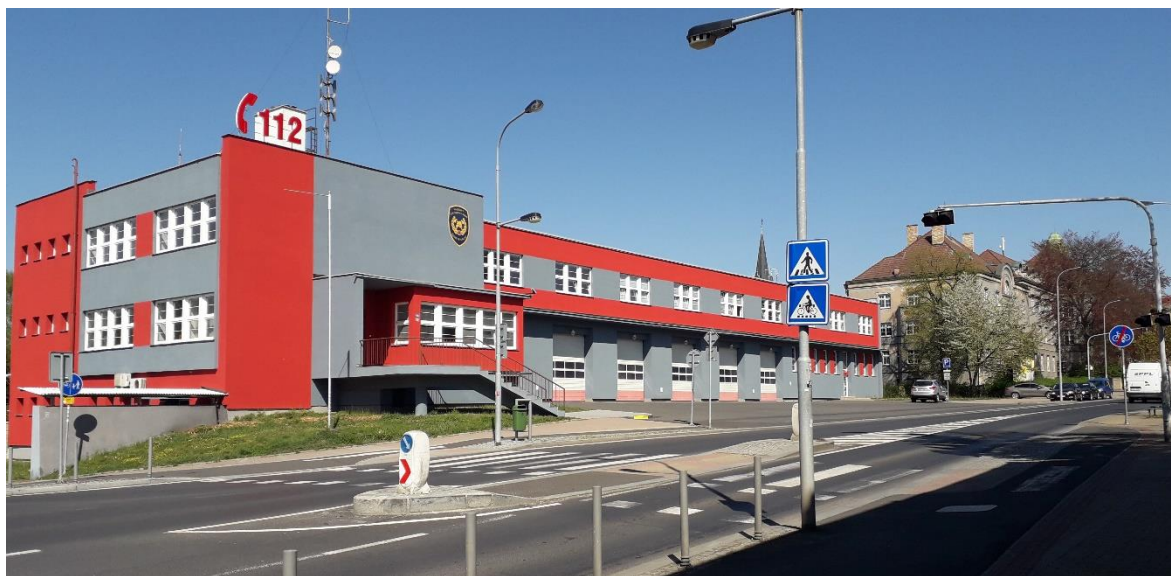
Obrázek 4 Stanice Karlovy Vary
