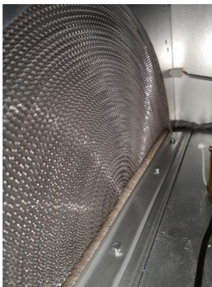
Obrázek 5 Rotační regenerační výměník tepla (detail)
