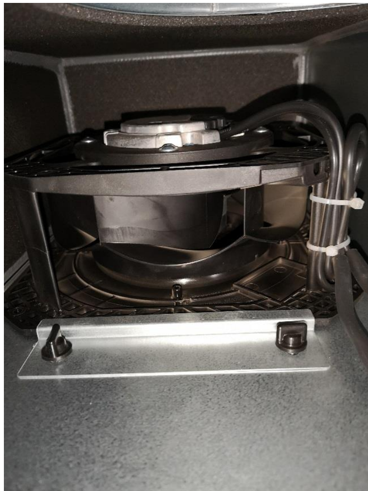
Obrázek 3 Ventilátor EBM – PABST K3G190-RD45-14
