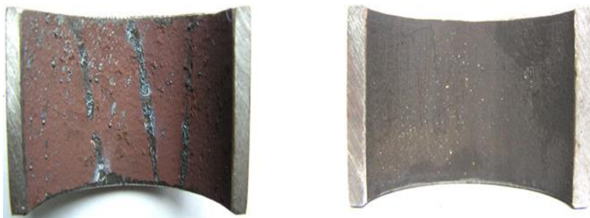
Obrázek 10. Vzorek potrubí před a po chemickém čištění a pasivaci [21].
