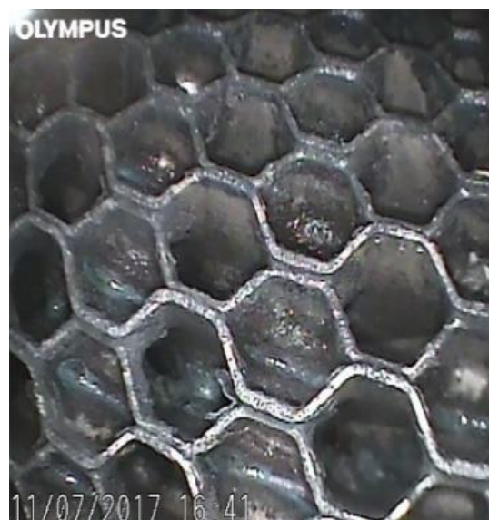
Obr. 19 - Endoskopický snímek vstupu primární strany výměníku po čištěním [36,37]na obrázku lze pozorovat výrazné zlepšení oproti obr. 18.
