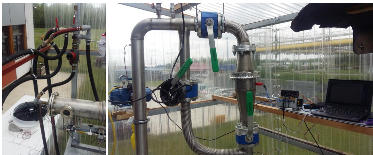
Obr. 47. Čtvrtá fáze výstavby APC a) křižovatka topné vody a zpátečky b) parní potrubí, připojení měření
