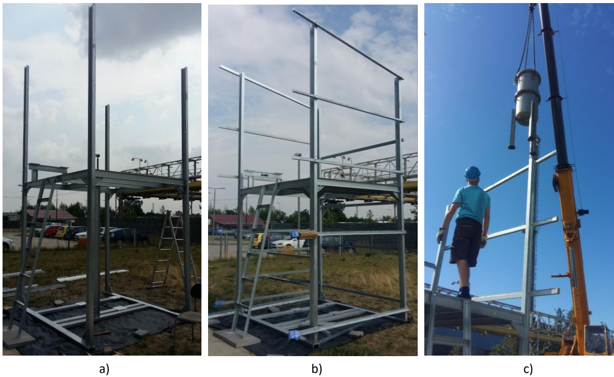
Obr. 45. První fáze výstavby jednotky APC
