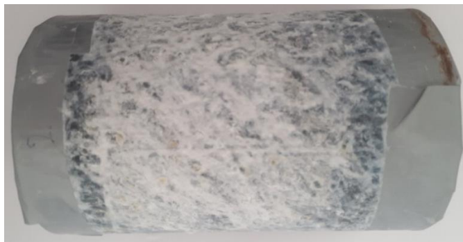
Obrázek 19 – Bílá rez na pozinkovaném povrchu trubky
